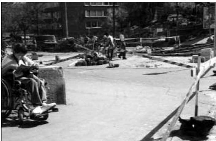
A Marczibányi tér és Garas utca sarkán megkezdődött az út átépítése.
