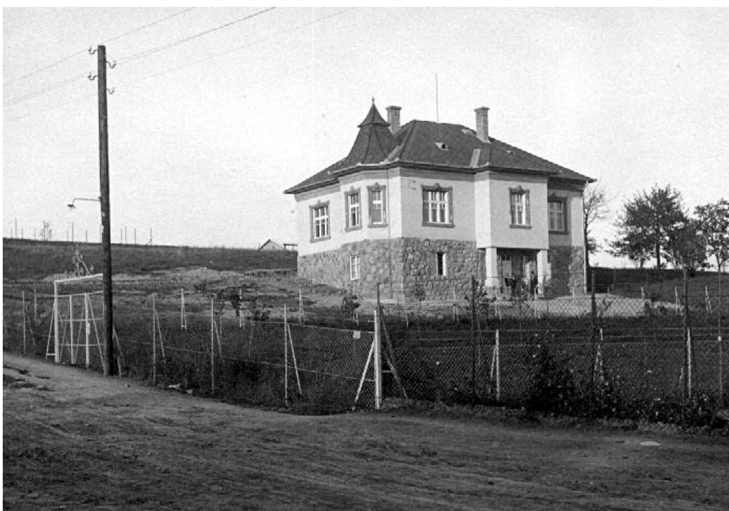
A domboldal beépítése a 30-as években kezdődött, először a 23-as, egy évre rá a 19-es, majd 1936-ban a 25-ös számú villa épült fel. A képen a mi házunk látható 31. őszén.
