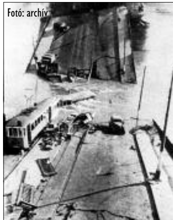
Fotó: archiv A lerombolt Margit-híd
