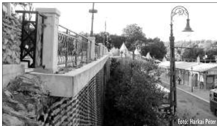
A támfal tetején levő kandelábertek oszlopán is jól látható a fal elmozdulása
