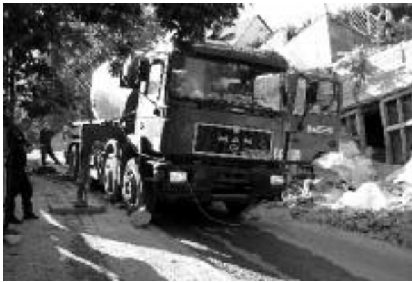
A betonkeverő gazdája „elfelejtett” engedélyt kérni, de nem került el a közterülfelügyelők figyelmét
