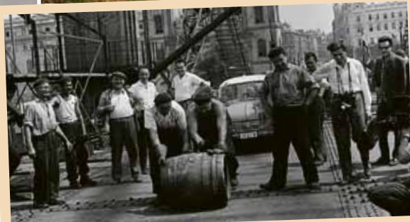
A hordógurítás hagyománya régi babonára vezethető vissza. Eszerint, aki elsőként kel át egy új hídon, azt balszerencse éri. Mivel ilyenkor általában a hordó az első, ezért azt éri a „balszerencse”, hiszen csapra verik, és elfogyasztják a tartalmát. Képünk az Erzsébet híd 1964-es átadásán készült.
