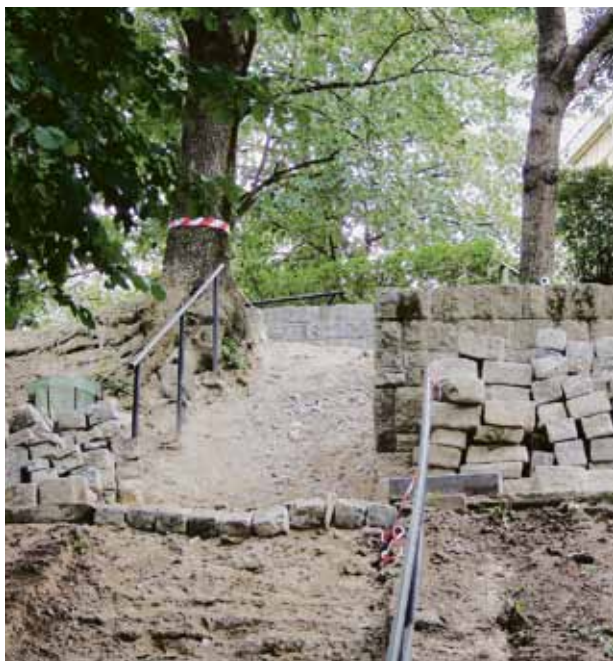
Megkezdődött a II. kerületi Polgármesteri Hivatal épülete mögötti lépcsősor és járda átépítése a Papkertben. A bazaltkockák helyett új, a biztonságosabb közlekedést segítő járdát és lépcsőt építenek. A rézsűben lévő járdafelület a jelenlegi beton kialakítás helyett térköburkolatot kap. A munkák előreláthatólag egy hónapig tartanak. Az arra közlekedők kerülőutakon közelíthetik meg a környéket. A munkálatok idejére a gyalogosok türelmét és megértését kéri.
