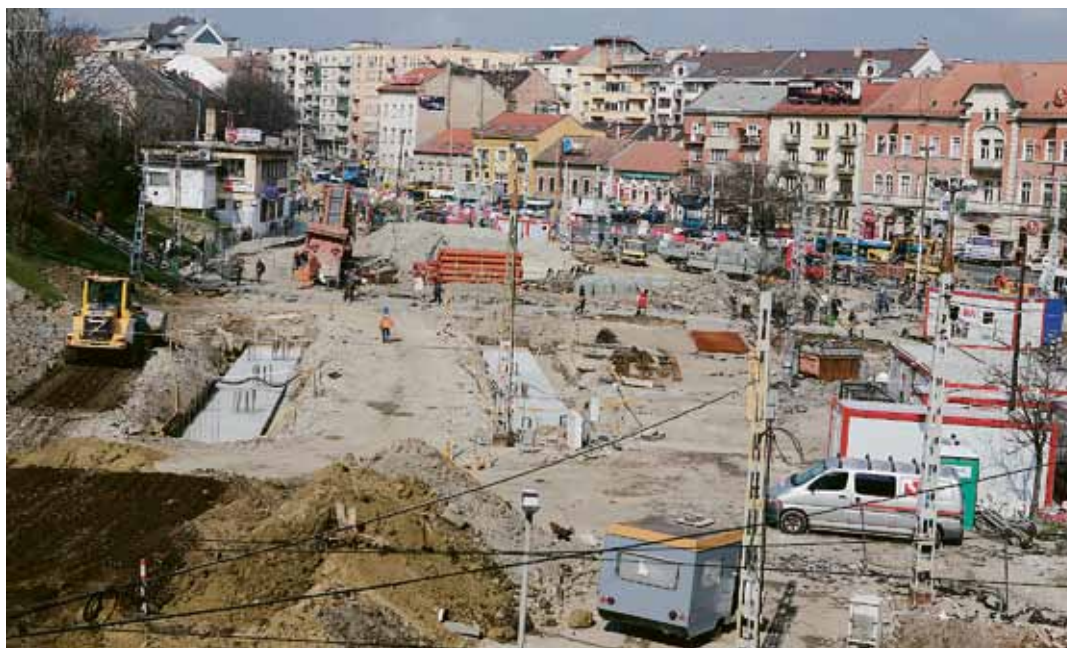
Márciusban már nemcsak bontottak, hanem megkezdődött az építómunka is
