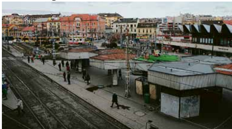
A Széll Kálmán tér közvetlenül a bontási munkálatok megkezdése előtt
