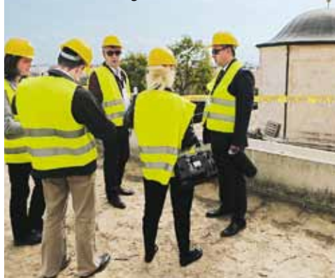
A küldöttség a Gül Baba türbe felújítási munkálatait is megtekintette
