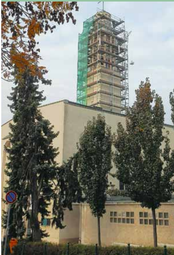
Az 1932-ben épült pasaréti téri templom tornyának elodázhatatlan felújítását már korábban megkezdtek, de a teljes rekonstrukcióhoz két éve láttak hozzá
