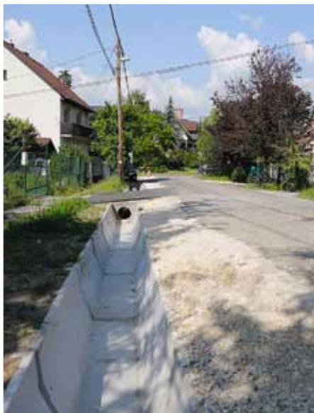
Befejezte a kivitelező a Muhar utcában a Szabadság utca és a Hidegkúti út közötti szakaszon a csapadékvízvezető-árok felújítását és burkolását. Hasonló munkálatok zajlanak a Kardos és a Járóka utcánál
