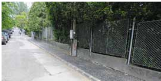
A járdaépítési munkálatok keretében dolgoznak a Harangvirág utca páratlan oldali burkolatának kialakításán. Szintén megújul a járda az Apostol utca 26. szám és a Kavics utca közötti szakaszon
