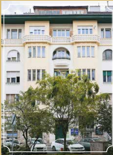
A Henger, illetve a Tölgyfa utcára néző homlokzat
