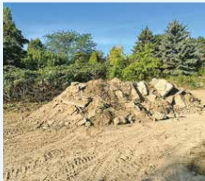
A Csalit utca–Csatárka út–Szikla utca közötti területen földmunkák zajlanak a parkosítás előkészítése érdekében
