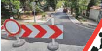
Új aszfalt és vízvezeték árok a Táltos utcában
